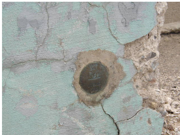
Figure 7 : Dégradation des repères altimétriques
